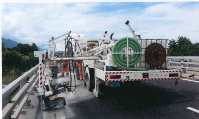
Le viaduc de l'Isère.
